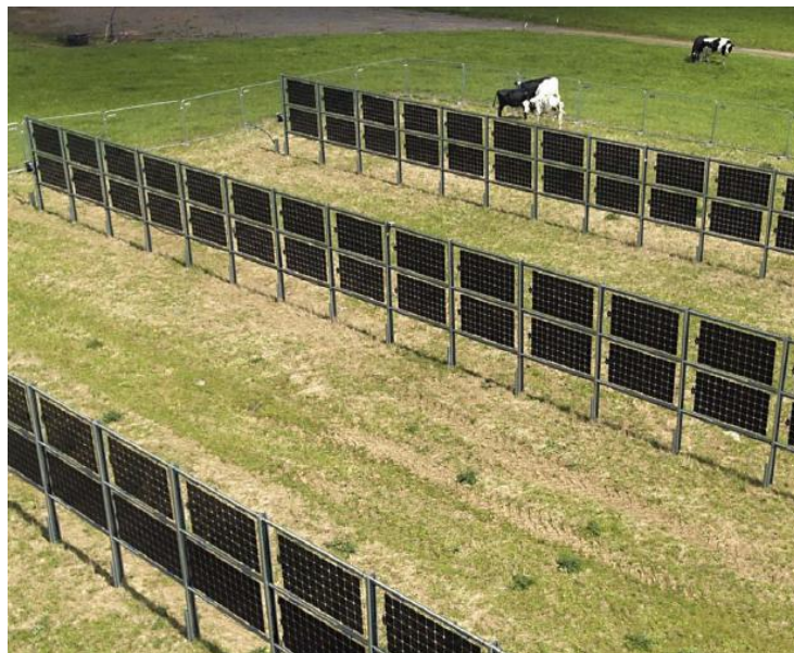
Die Modulreihen stehen mit zehn Metern Abstand zueinander, um Verschattungen zu minimieren. Aus demselben Grund müssen auch die Module selbst seitlich etwas Abstand zum Montagesystem halten.
