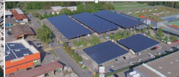
Mit dem «Solarparkplatz» deckt die Migros im Einkaufszentrum Chablais in Aigle rund die Hälfte ihres Stromverbrauchs. Die Eigenverbrauchsquote liegt bei 70% (Bild: © Romande Energie).
