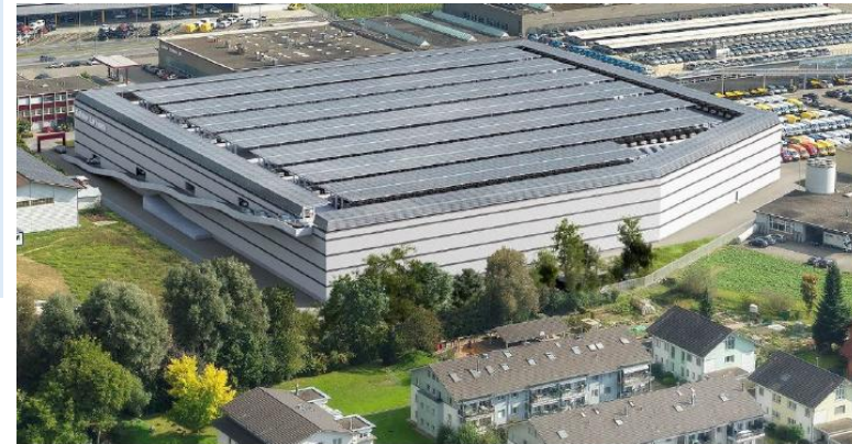
2.1 MWp Parkplatzüberdachung bei der Firma Galliker Transport & Logistics in Altishofen
