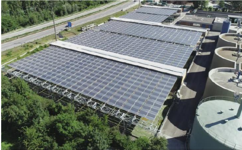
5: In der ARA Chur wurden die Klärbecken mit einer einfahrbaren Falt-PV-Anlage überdeckt (Bild: © dhp).
