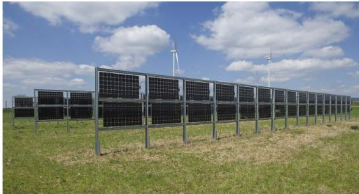
Die Modulreihen stehen mit zehn Metern Abstand zueinander, um Verschattungen zu minimieren. Aus demselben Grund müssen auch die Module selbst seitlich etwas Abstand zum Montagesystem halten.
