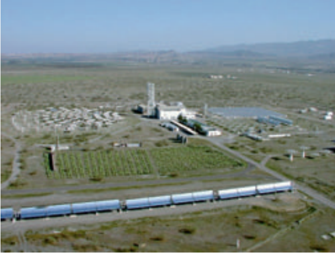
4.14 Auf dem Gelände der «Plataforma Solar» in der Nähe von Almeria (Spanien) werden die verschiedenen Anlagenkonzepte seit mehreren Jahren unter Realbedingungen erforscht.
