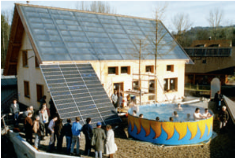
«Nullenergiehaus» (erbaut 1989) in Oberburg, Kanton Bern/Schweiz
