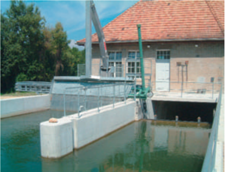
4.20 Saniertes Kleinwasserkraftwerk. Bild ADEV Energiegenossenschaft.
