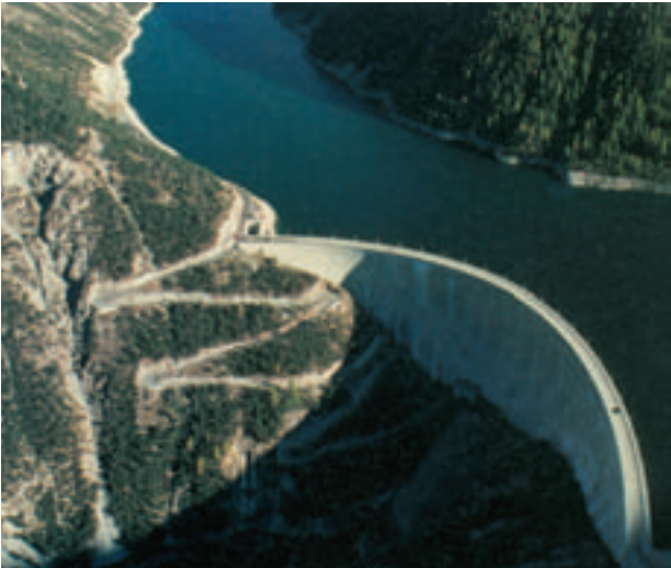
4.2 Wasserkraftwerke sind seit über 100 Jahren fester Bestandteil der Stromversorgung. Hohe Anfangsinvestitionen und eine sehr lange Lebensdauer sind charakteristisch.
