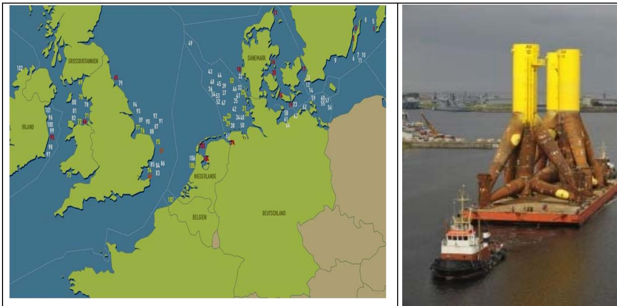
**Figur 86 über Hundert offshore Windfarmen sind geplant, davon****Figur 87 Offshore-Verankerungen werden auf dem Land gebaut und ins Meer verschifft**
