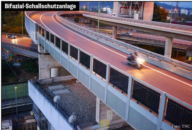
Auf der Autobahnbrücke Aubrugg (Zürich) nahm 1997 die weltweit erste Bifazial-Schallschutzanlage den Betrieb auf. Sie ist in Nord-Süd-Richtung auf Morgen- und Abendsonne ausgerichtet; am Mittag erbringt sie einen reduzierten Ertrag. Ihr Jahresertrag ist gleich hoch wie von einer monofazialen, süd-gerichteten Solaranlage. Neuere bifaziale Solarmodule liefern mehr Energie als monofaziale Module; ihr Preis ist nahezu derselbe.
