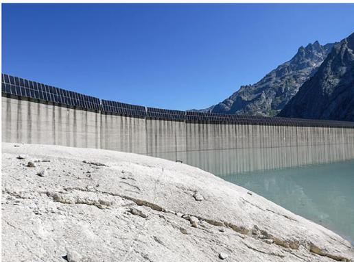
Im Bergell hat die ewz die erste PV-Anlage der Schweiz an einer Staumauer verwirklicht (Bild: © ewz)
