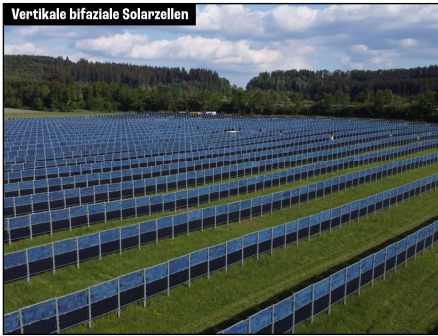
Vertikale bifaziale Solarzellen
