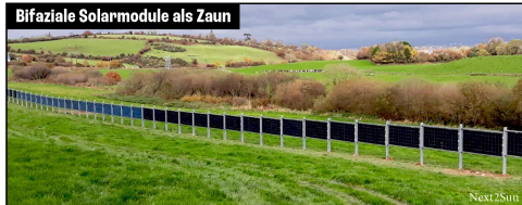
Bifaziale Solarmodule als Zaun
