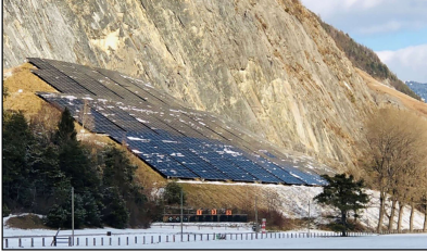
Solaranlage auf dem Steinbruch Calinis (Felsberg GR)
