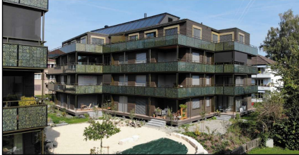
Dächer, Fassaden, Balkone definieren Ausrichtung der Solarmodule
