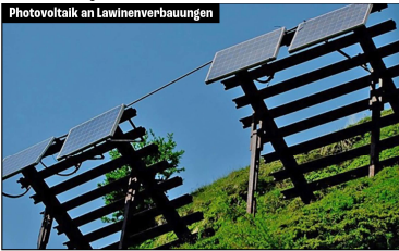
Photovoltaik an Lawinverbauungen
