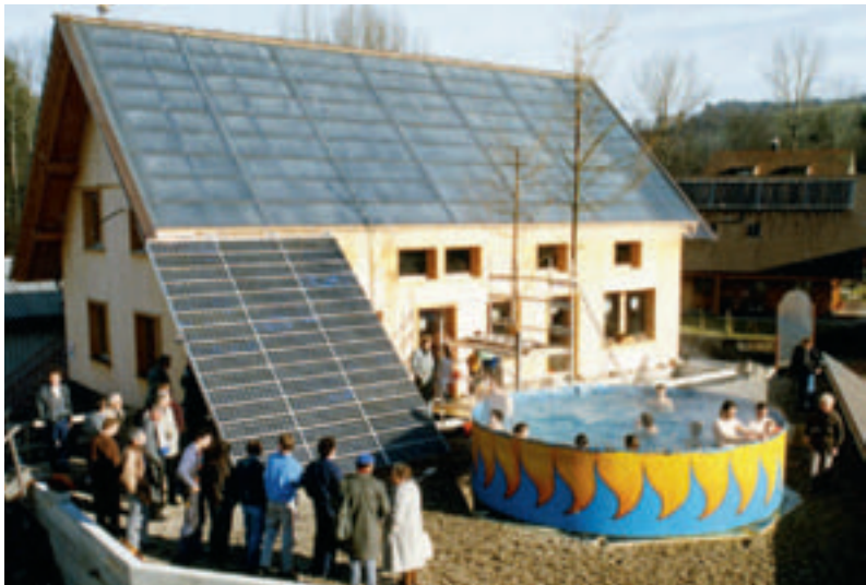
«Nullenergiehaus» (erbaut 1989) in Oberburg, Kanton Bern/Schweiz
