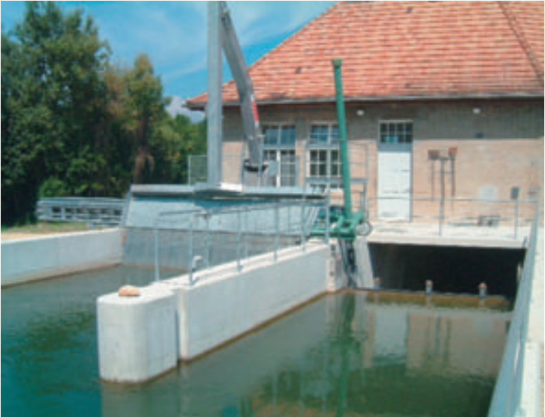
4.20 Saniertes Kleinwasserkraftwerk. Bild ADEV Energiegenossenschaft.
