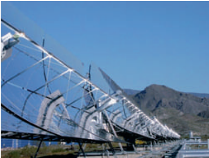
4.15 Parabolrinnenkollektoren, wie sie auch in Kalifornien verwendet werden. Die Einfallende Sonnenstrahlung wird auf die Röhre in der Mitte gespiegelt. Dort wird die Trägerflüssigkeit auf mehrere Hundert Grad erhitzt und betreibt anschliessend ein konventionelles Dampfkraftwerk.
