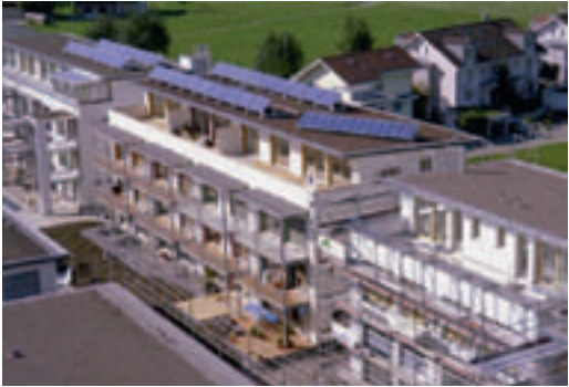
4.8 Acht-Familien-Passivhaus in Stans, Zentralschweiz (Solarpreis 2002). Passive Sonnenenergie durch grosse Fensteröffnungen, 30 cm Steinwolle an der Nordfassade, auf dem Flachdach 42 m 2 Warmwasserkollektoren und 1.4 kW Solarzellen installiert. Bild SSES 12
