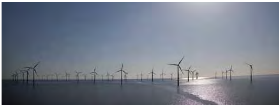
Robin Rigg in der Irischen See erzeugt mit 60 Turbinen der Marke Vestas V90-3 MW rund 550'000'000 kWh pro Jahr. Gesamtinvestitionen: 420 Millionen Euro. Quelle: E.on / E.on Offshore Factbook (2011).
