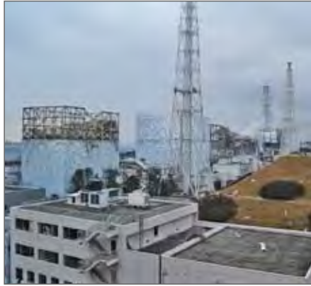
Blick auf die vier explodierten Reaktoren am 15. März 2011 (Bild: Tepco)
