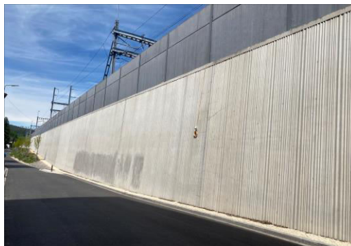
Abbildung 30 Beispiel neuer SBB Bahnhof Liestal: kilometerlange Stützmauern, Lärmschutzwände, Perrons, aber keine PV-Anlagen
