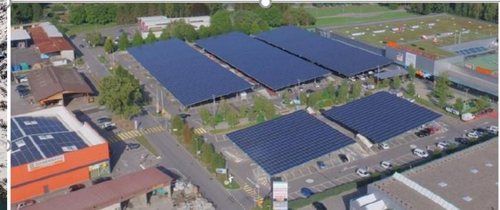
Abbildung 8: Mit dem «Solarparkplatz» deckt die Migros im Einkaufszentrum Chablais in Aigle rund die Hälfte ihres Stromverbrauchs. Die Eigenverbrauchsquote liegt bei 70% (Bild: © Romande Energie).
