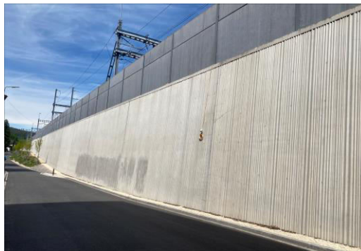
Abbildung 23 Beispiel neuer SBB Bahnhof Liestal: kilometerlange Stützmauern, Lärmschutzwände, Perrons, keinerlei PV
