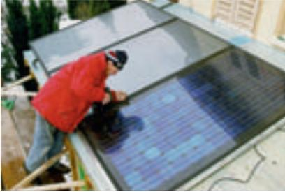
4.10 Kombianlage thermisch/photo-voltaisch, Solar-Compactline, 4,5 m<sup>2</sup> Kollektor und PV Anlage 2,25 m<sup>2</sup>, Deckungsgrad im EFH: 60% für Warmwasser, 7% für Strom. Bild SSES
