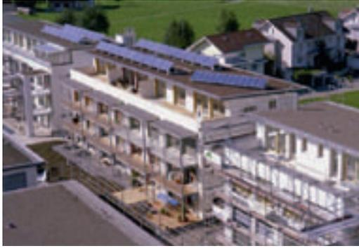
4.8 Acht-Familien-Passivhaus in Stans, Zentralschweiz (Solarpreis 2002). Passive Sonnenenergie durch grosse Fensteröffnungen, 30 cm Steinwolle an der Nordfassade, auf dem Flachdach 42 m<sup>2</sup> Warmwasserkollektoren und 1.4 kW Solarzellen installiert. Bild SSES<sup>12</sup>
