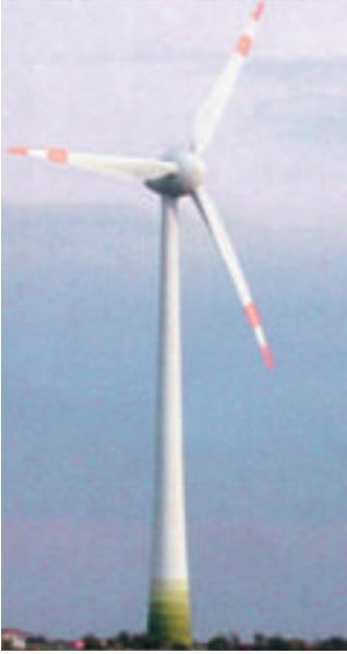
5.1 Dieser 4,5 MW-Prototyp des deutschen Herstellers Enercon liefert an einem Standort in der Nord- oder Ostsee Strom für 5–10'000 Haushalte und kann damit eine Kleinstadt mit Strom versorgen.
