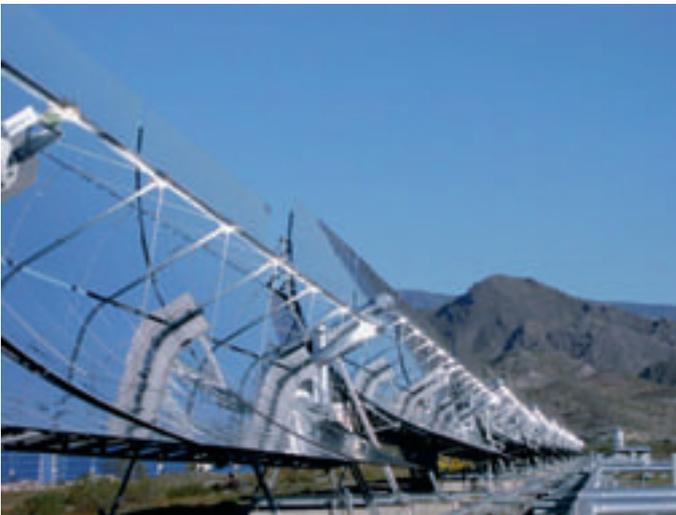
4.15 Parabolrinnenkollektoren, wie sie auch in Kalifornien verwendet werden. Die Einfallende Sonnenstrahlung wird auf die Röhre in der Mitte gespiegelt. Dort wird die Trägerflüssigkeit auf mehrere Hundert Grad erhitzt und betreibt anschliessend ein konventionelles Dampfkraftwerk.
