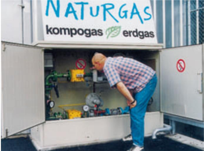
4.6 Seit 1996 wird Biogas, erzeugt aus Küchen- und Gartenabfällen, ins Zürcher Gasleitungsnetz eingespeist. Das «Kompogas»-Verfahren ermöglicht auch die Herstellung von CO<sub>2</sub>-neutralem Fahrzeugtreibstoff. Bild VSG.
