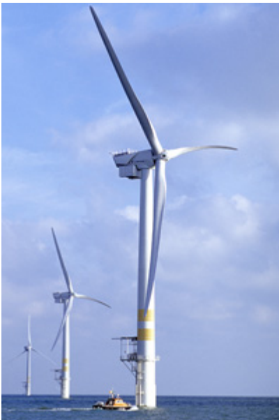
Abbildung 5 Windenergie trägt ihre Kosten. Bei Unfällen deckt eine Haftpflichtversicherung alle Verpflichtungen. Atomkraftwerke haben keine Haftpflichtversicherung.
