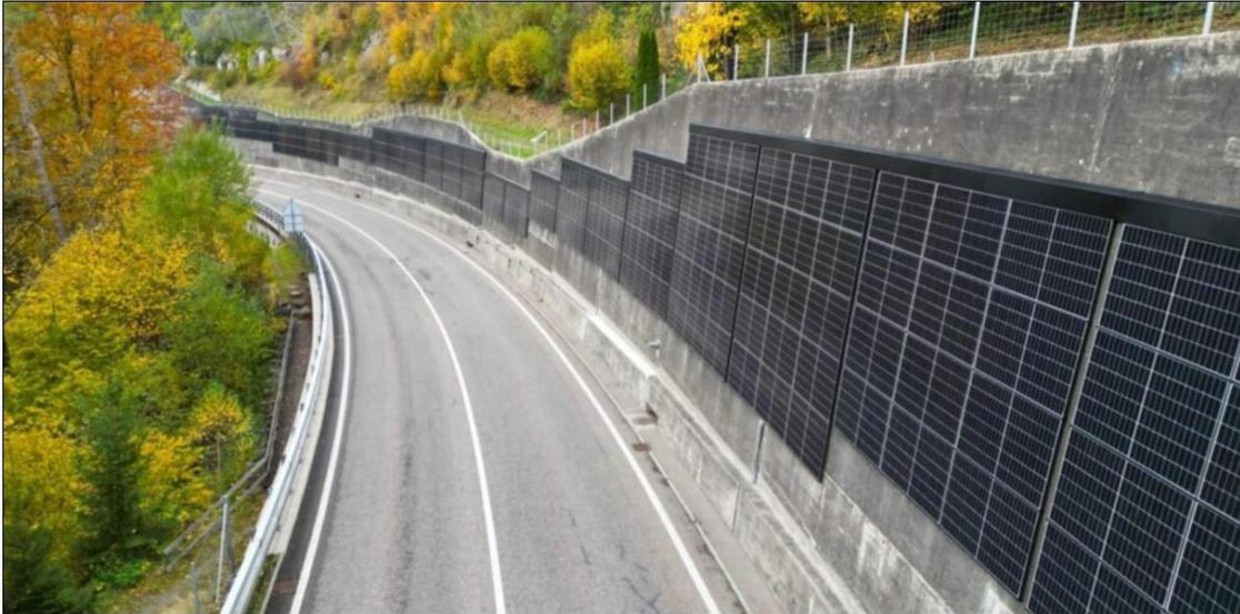
Abbildung 24 Stützmauer mit PV, Appenzell
