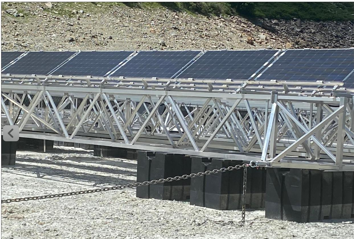
**Abbildung 23 Lac de Toules: materialintensiver Unterbau, Kosten >5000 CHF/kW**
