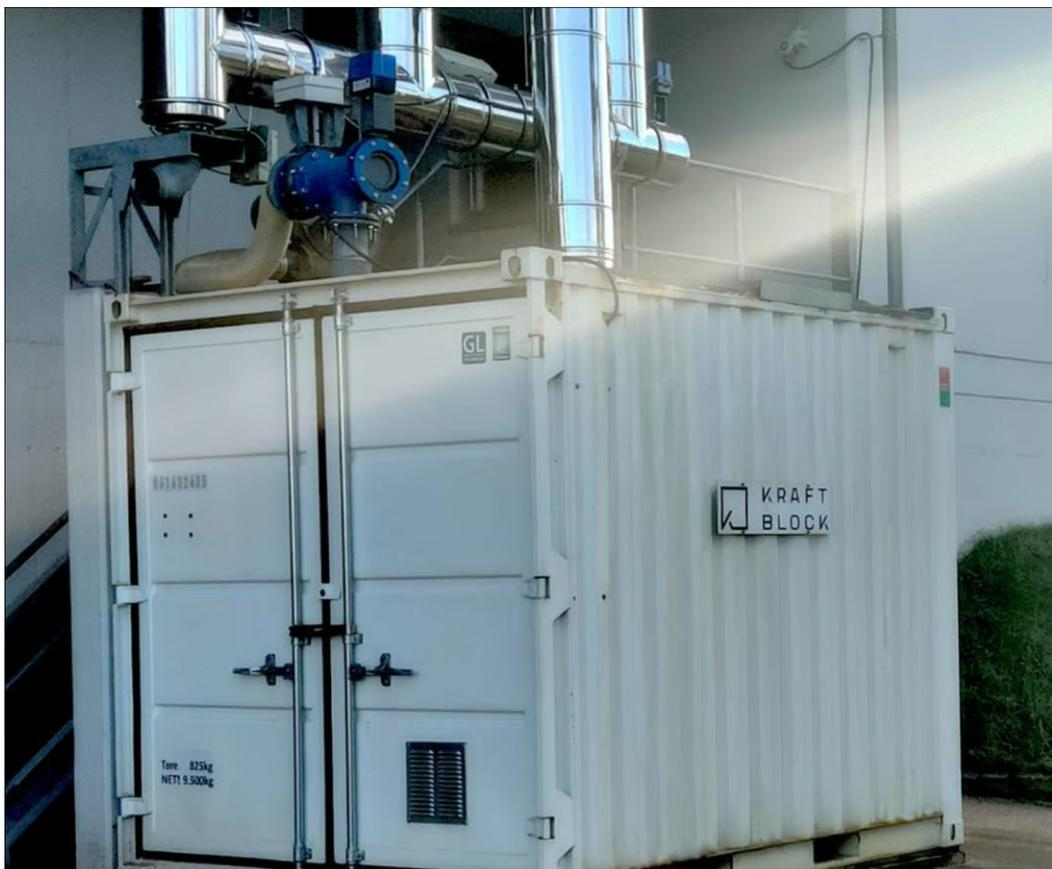
**Abbildung 10 Kraftblock-Wärme-Container: Der Wärmespeicher des Start-ups kommt in Pilotprojekten in der Keramikindustrie und bei der Baustellentrocknung zum Einsatz. Foto: Kraftblock**
