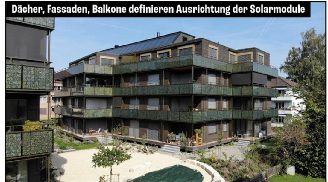
Ersatzneubau in Zürich-Altstetten mit umlaufender Photovoltaik (Bild Megasol Energie AG)
